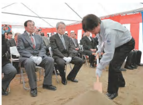
神事で工事の安全を祈願する関係者
